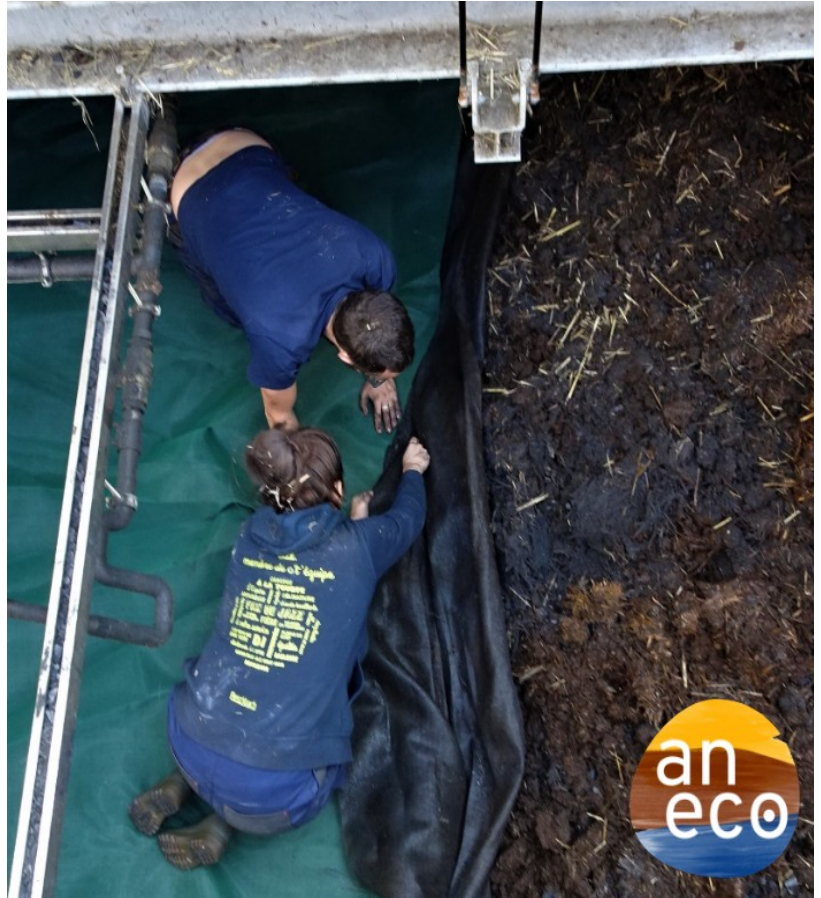
Intervention sur le lombrifiltre de Soubeyran, avec 300kg de vers de terre pour assainir les besoins d'une centaine de personnes
