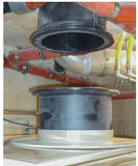
La pose des tuyaux verticaux comporte une certaine imprécision, notamment à cause des déformations du plastique PE exposé au soleil. La position des tuyaux au sous-sol varie de +/- 4 cm. Pour compenser cette imprécision, le toit des composteurs a été percé d'un trou plus large permettant
