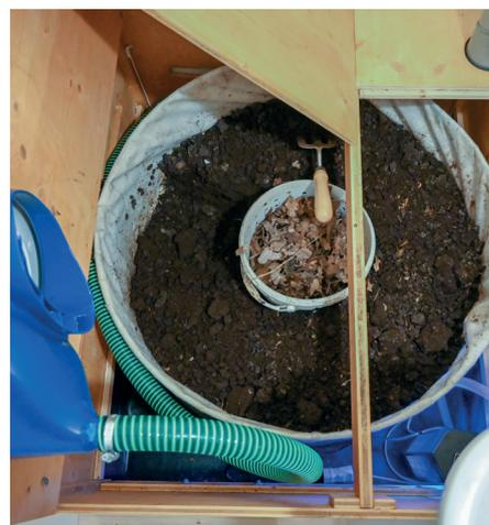
L'image de gauche ci-dessus illustre le cacarrousel installé dans un local WC de dimensions 84x160 cm. L'image du centre montre le tuyau qui permet d'évacuer l'urine via une conduite souple avec un siphon pour bloquer les odeurs<sup>4</sup>. L'image de droite illustre l'intérieur du composteur avec son plateau tournant et un seau au centre pour servir de refuge – «nursérie» ou «pouponnière» – pour les vers de terre. Ce seau n'accueille pas nos déjections mais plutôt
