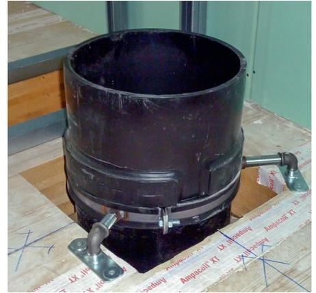
Une pièce amovible de 60 cm permet de faire le raccord avec le composteur. Les tuyaux ont été posés d'une seule pièce. Les plus grands, au deuxième étage, mesurent environ 7 m et ont nécessité une grue pour la pose.
